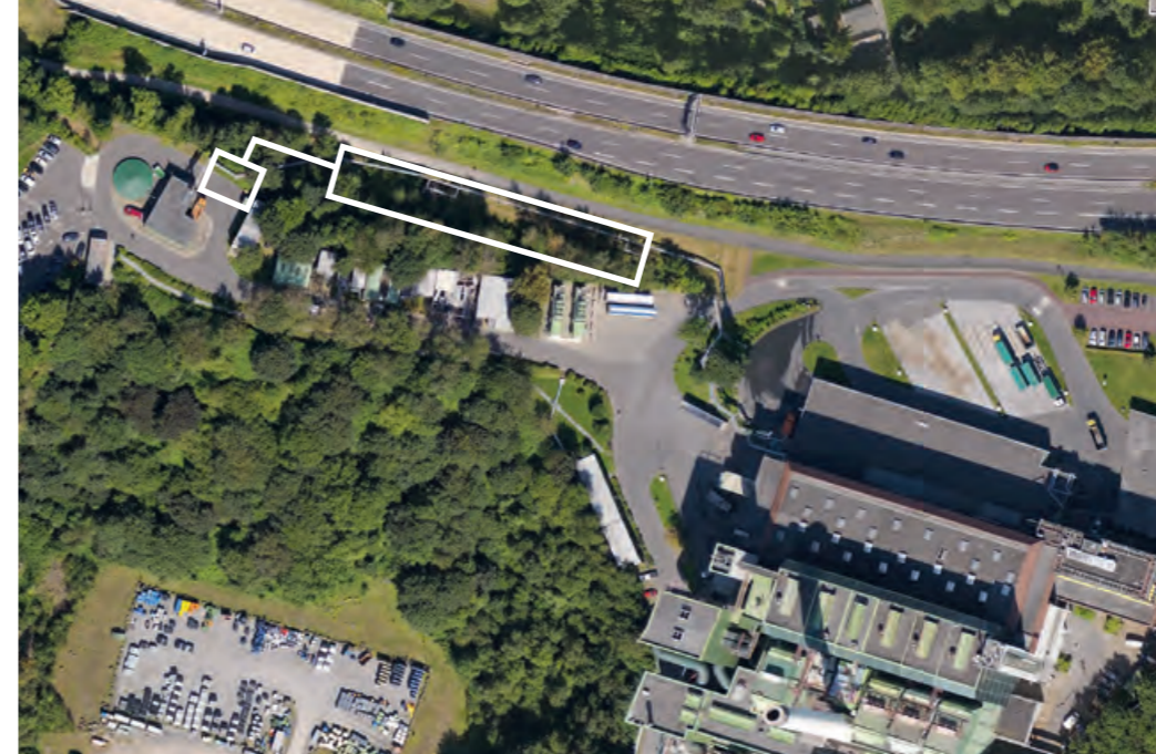
Standort für die Wasserstoff-Infrastruktur am MHKW Wuppertal Quelle: Land NRW (2017) / GeoBasis-DE/ BKG 2017
